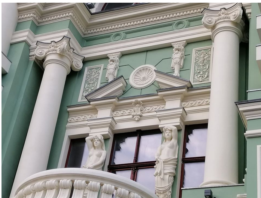
Рис. 7. Воссозданный пластический декор фрагмента центральной композиции парадного фасада дома Руссова в Одессе. Фото В. Тенякова
